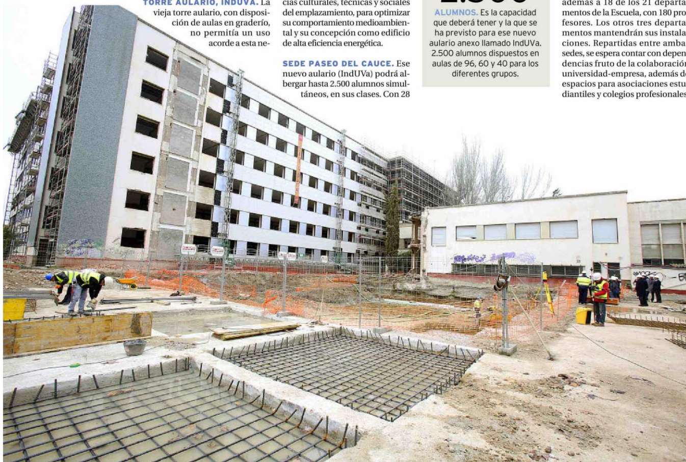
Obras que se están llevando a cabo en la antigua facultad de Ciencias. / FOTOS: CARLOS BARRENA (UVA)
