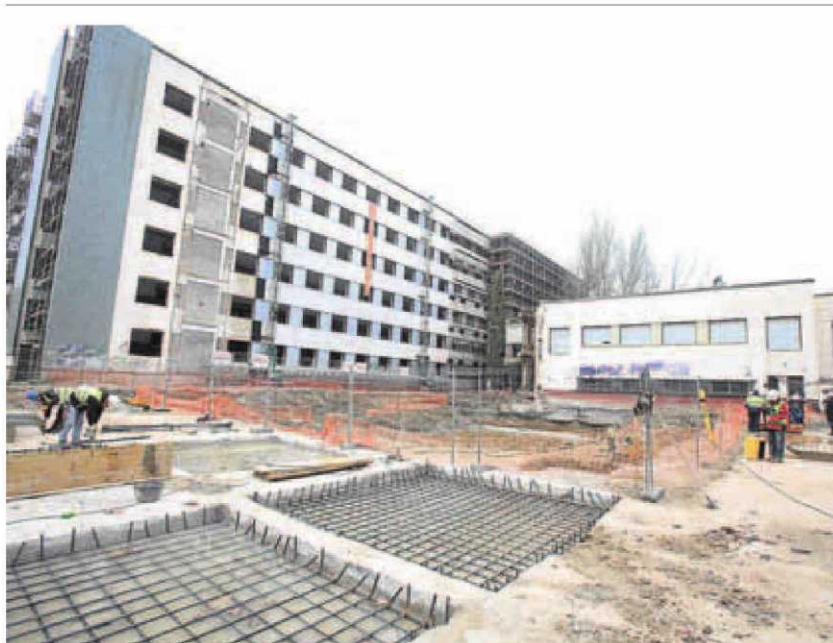
Trabajos de cimentación del nuevo aula, en la fachada que mira al Esgueva. :: C. BARRENA-UVA
